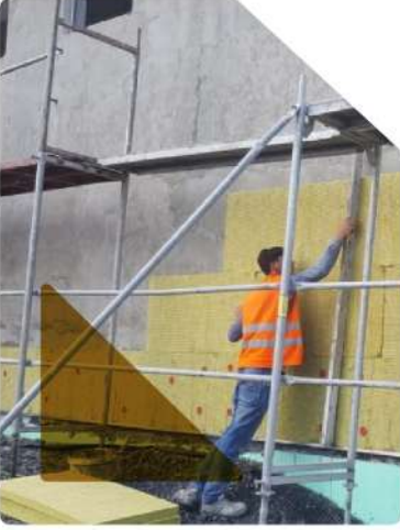
Taş Yünü Uygulaması
